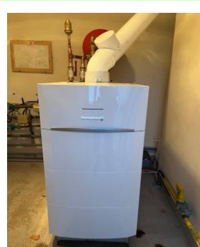
Remplacement de la chaudière salle polyvalente
